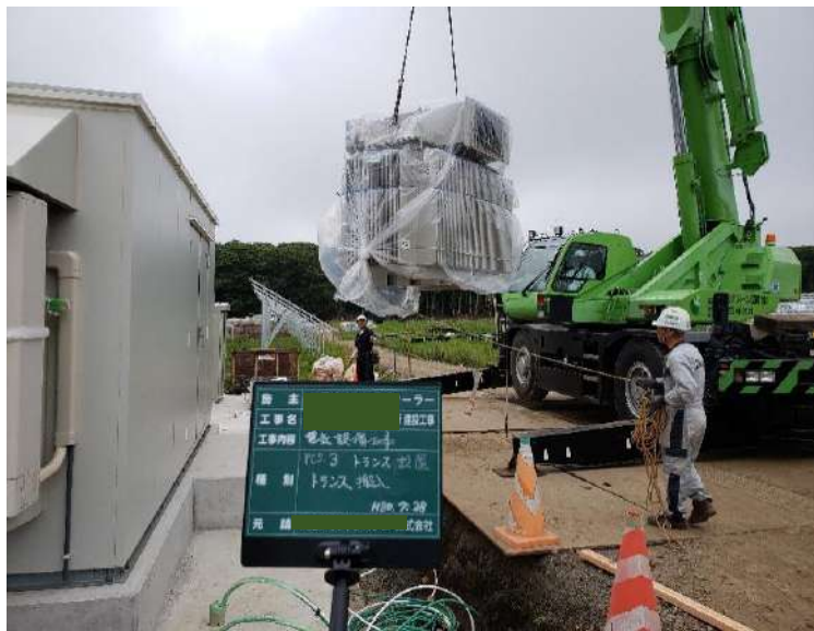
PCS 特高トランス設置
