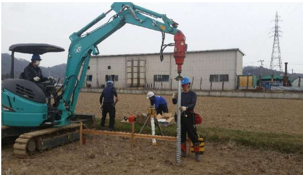
スクリー杭打設
