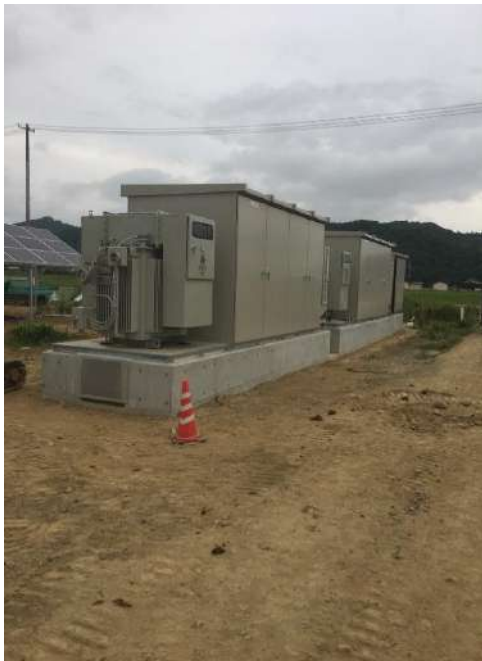
キュービクル設置
