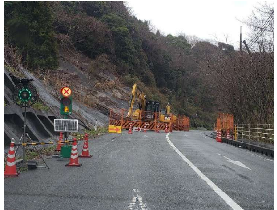
自営線工事33kV
