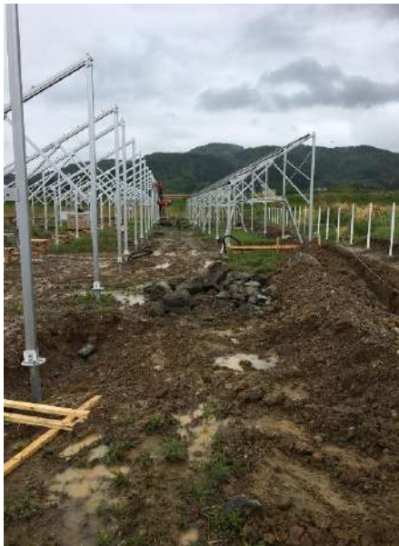
パネル架台組立
