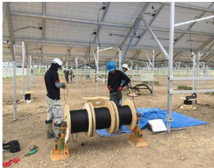
PV回路 延長ケーブル敷設
