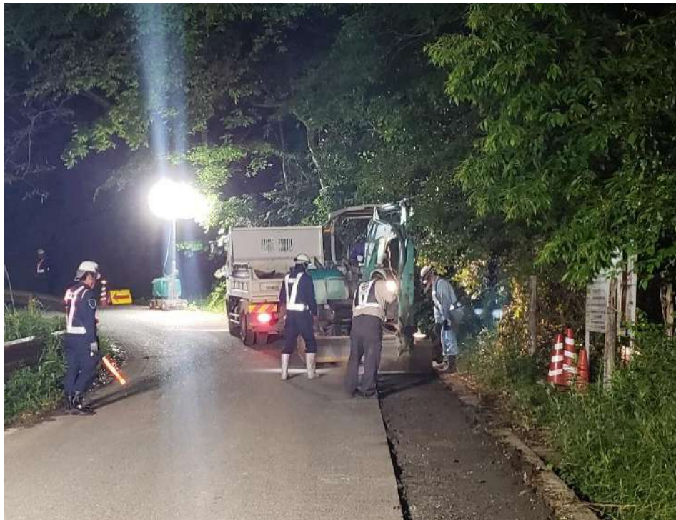
自営線夜間工事
