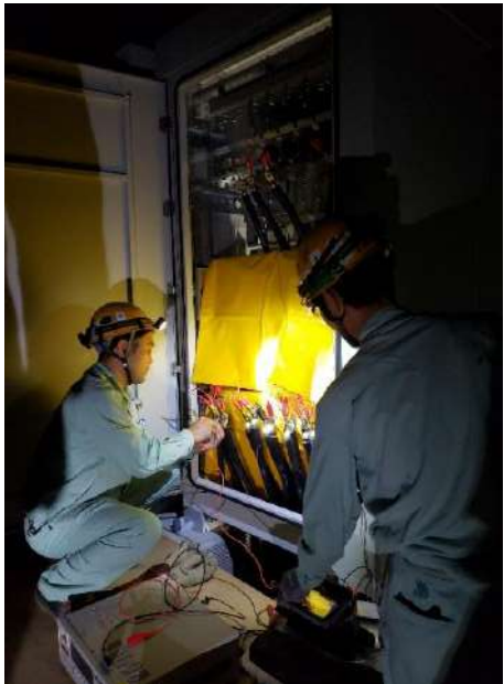
DC回路 絶縁耐力試験
